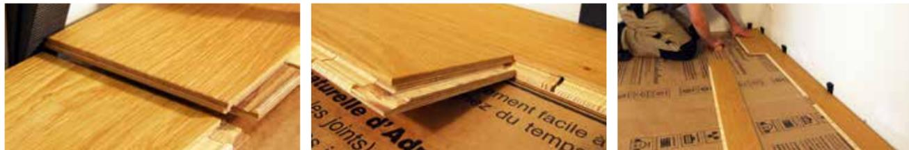
Ab der zweiten Reihe werden die Dielen längsseitig in einem Winkel von 30° in die Nut der vorigen Reihe gelegt und anschließend nach unten geklappt. Der Versatz zwischen Stirnstößen benachbarter Reihen muss mind. 30 cm betragen.
